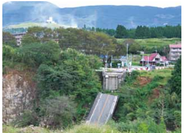
(阿蘇大橋の崩落現場)
