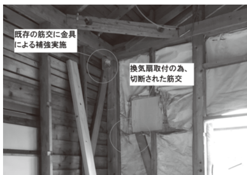
▲既存筋交いの補強と、切断された筋交いの交換
