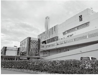
クリーンエネパーク南部施設工場平成29年に火災事故が発生し4億8400万円の損害が出ました
