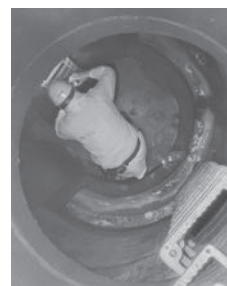
市職員による点検の様子
