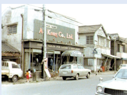
アーコンテイラーの外観
