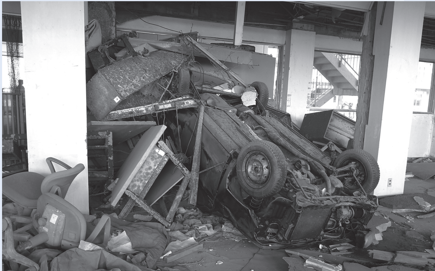
▲気仙沼市東日本大震災遺構・伝承館（3日目）
