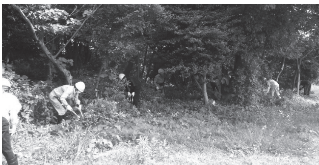
水城跡で作業の様子
