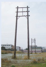
板付基地で使用されていた電柱
