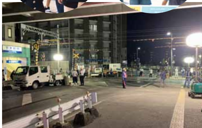
高架切替にむけた踏切撤去作業
