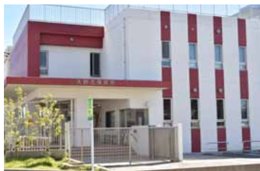
大野北小学校隣から御笠の森小学校隣に移転・新築した大野北保育所
