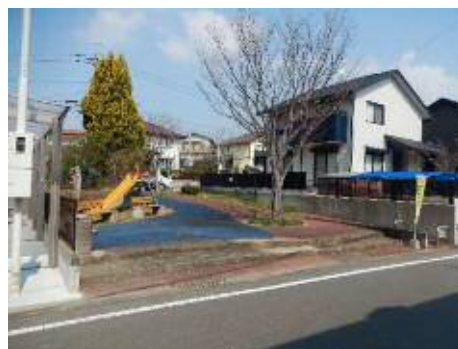
通路として利用されている公園内にある滑り台の様子
