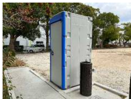
トイレの設置
