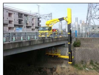
委託点検状況
