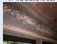
熱間圧延によって製造された形鋼を用いている鋼橋
