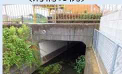
小規模な鉄筋コンクリートの剛体ボックス構造
