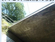
版単体で上部構造が成立している構造
