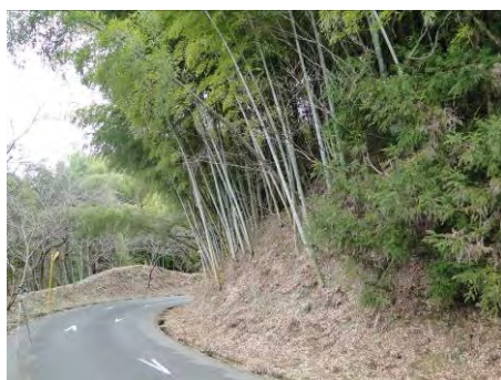
のり面に進出したモウソウチク、倒れた箇所は浸食が始まっている（山神ダム）
