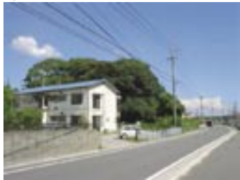
JR水城駅側から見た水城跡。隣接する2階建てアパートよりも高く生い茂った樹木。
