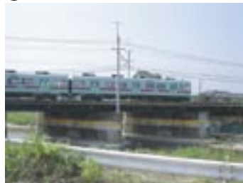
水城跡を貫通する西鉄大牟田線の線路。
