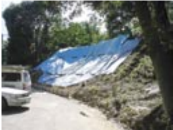
近年大雨による崩落箇所。 復旧中。
