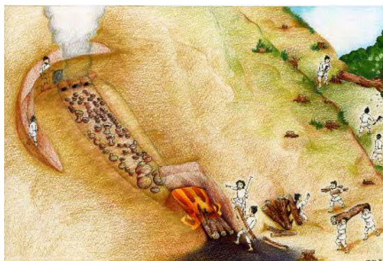
多孔式煙道窯の操業の様子（古墳時代） イラスト：岩本 恵
