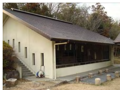
窯跡の覆屋保存 (京都府木津川市、音如ヶ谷瓦窯跡)
