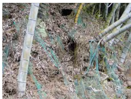
のり面に進出したモウソウチク、倒れた箇所は侵食が始まっている
