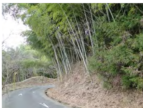
のり面に進出したモウソウチク、倒れた箇所は侵食が始まっている
