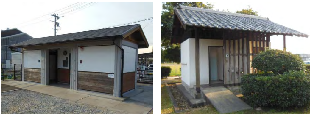
図 8-21: 東門エリアに設置されているトイレの様子
