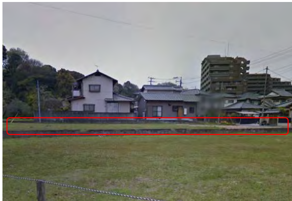
図 8-41:計画地に設置されている擁壁
