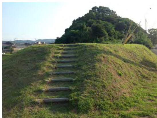
図 8-6: 階段の設置例(欠堤部外濠広場周辺)
