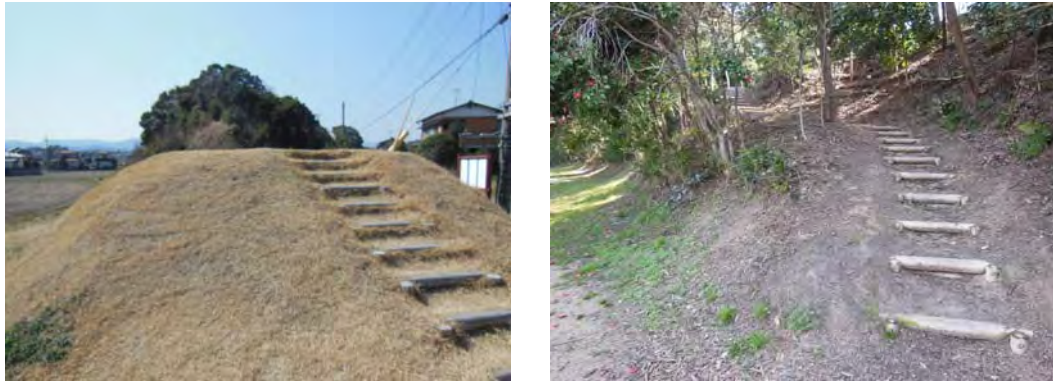
図 7-3: 既設のアプローチ階段【いずれも中央エリア】
