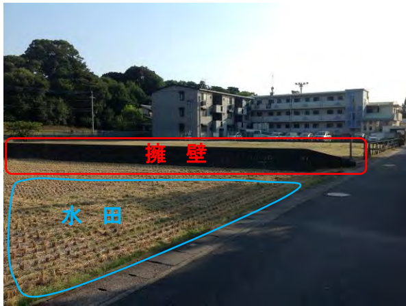
図 8-67: 擁壁と水田の状況
