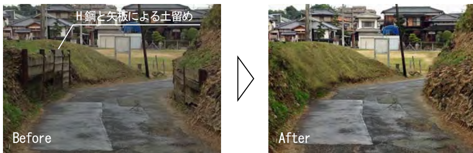
図 8-46: 欠堤部を通る車道と土塁の崩落を防ぐために設置されたH鋼と木板
