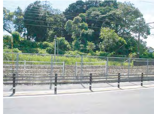
図 2-8:JR鹿児島本線で分断された水城跡
