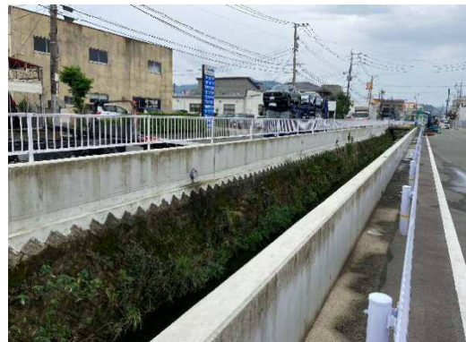
水路護岸嵩上げ
