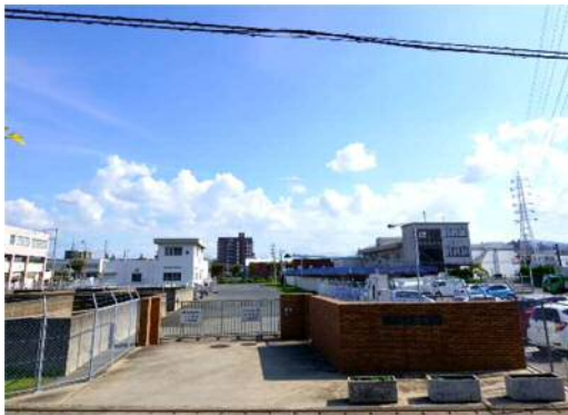
瓦田浄水場（正門）
