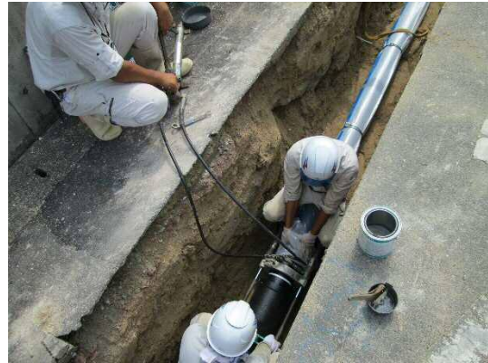
水道管の布設状況
