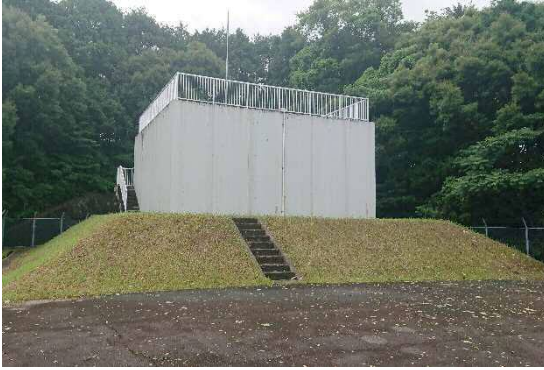
廃止する配水池
