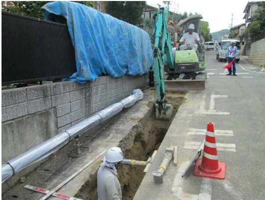
道路掘削状況
