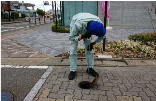
漏水調査の状況
