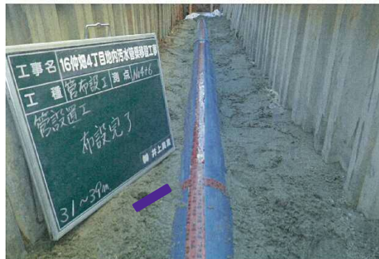
汚水管布設状況
