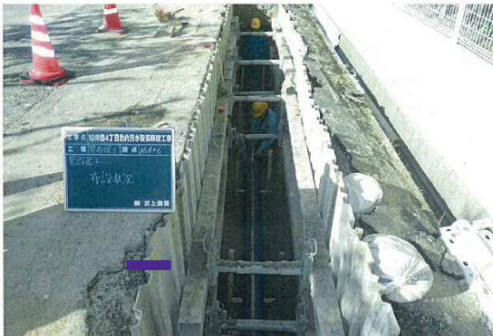
汚水管布設状況
