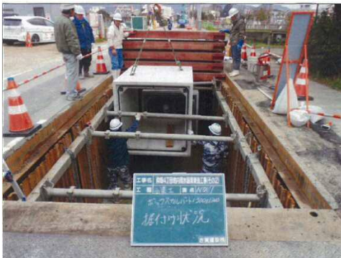
雨水函渠布設状況
